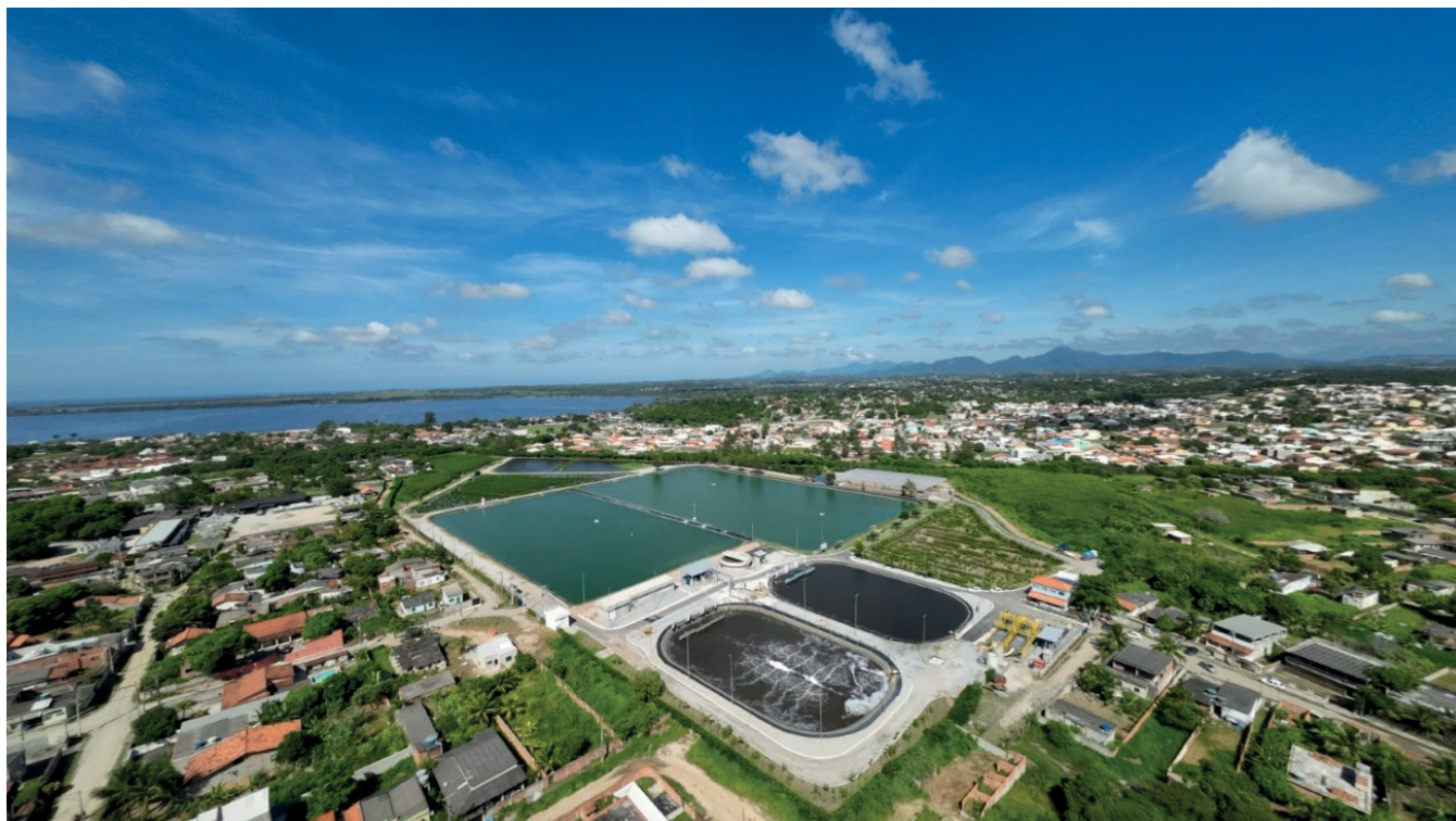
Estação de Tratamento Ponte dos Leites - Grupo Águas do Brasil/Águas de Juturnaíba
