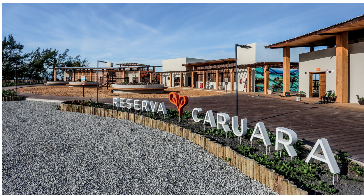
Sede da Reserva Caruara - Porto do Açu
